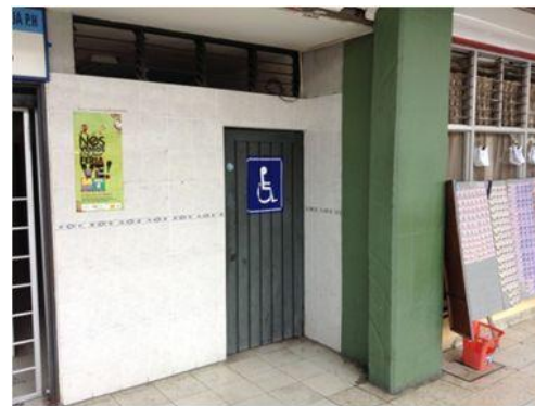
Baterías de baños nuevas para Personas discapacitadas. (Tulua)
