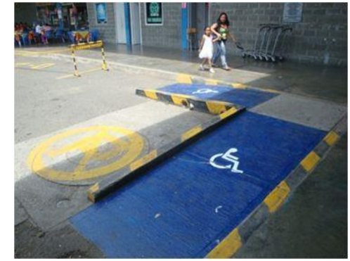
Demarcación rampas para personas discapacitadas. (Buga)
